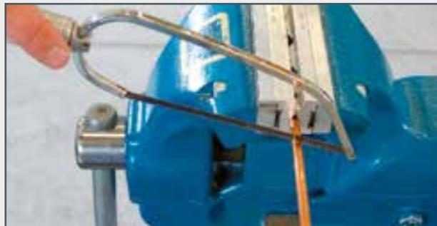
Déterminer la longueur du segment du tube. Ce faisant, il faut tenir compte des suppléments pour les opérations de pliage et d'agrafage. Scier le tube.
