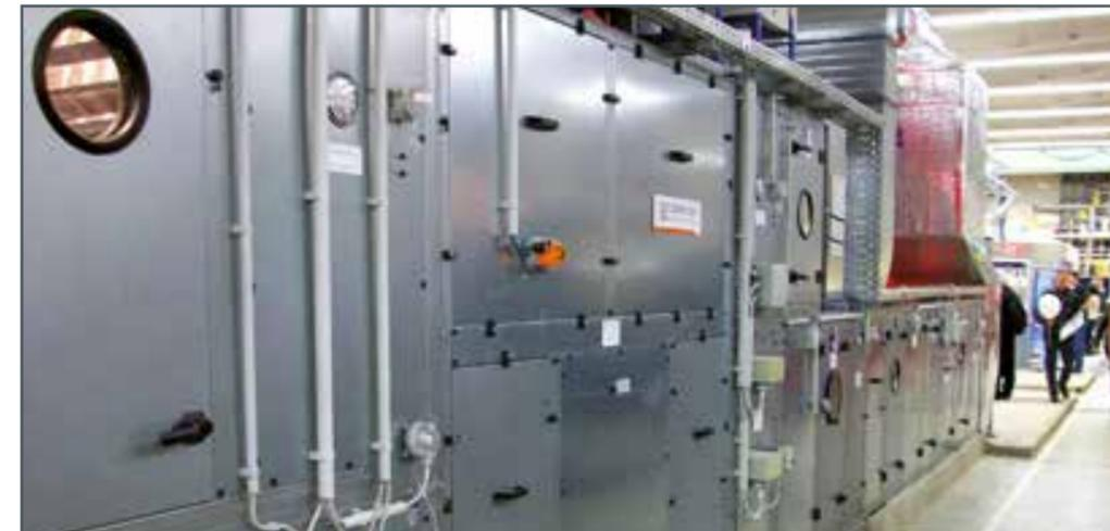
Un exemple emprunté à la pratique: des installations de climatisation industrielles équipées de grands filtres, pour la construction d'une salle blanche
