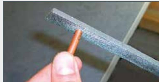
Limer la coupe de la scie, la surface de coupe devant se trouver dans un angle droit avec l'axe du tube
